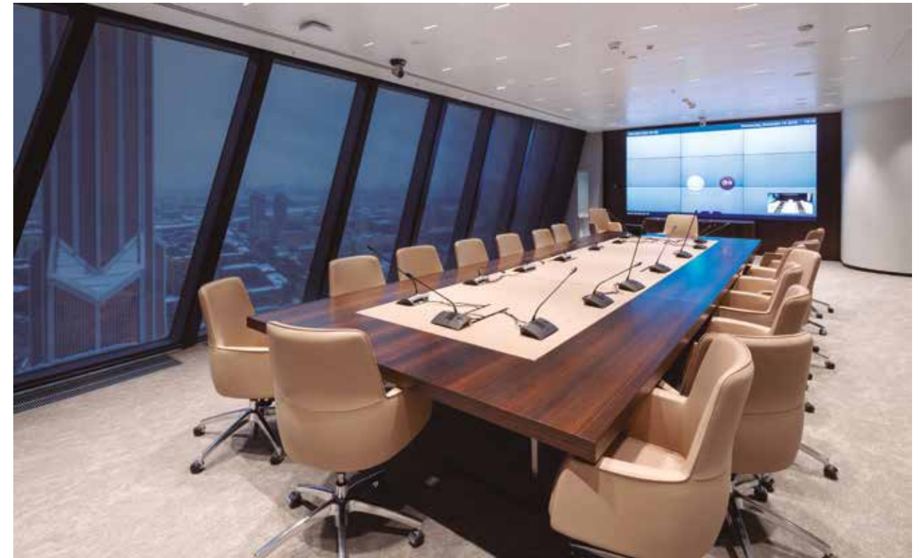
A sala de reuniões foi iluminada com equipamentos lineares da mesma família, com refletores de alto contraste, com LEDs 10 W, 920 lm, 4.000 K, e fecho de 48°, evitando ofuscamentos e reflexos na tela ao fundo da sala.
